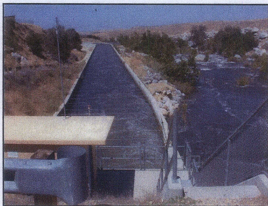
Rio Bravo Power Canal
